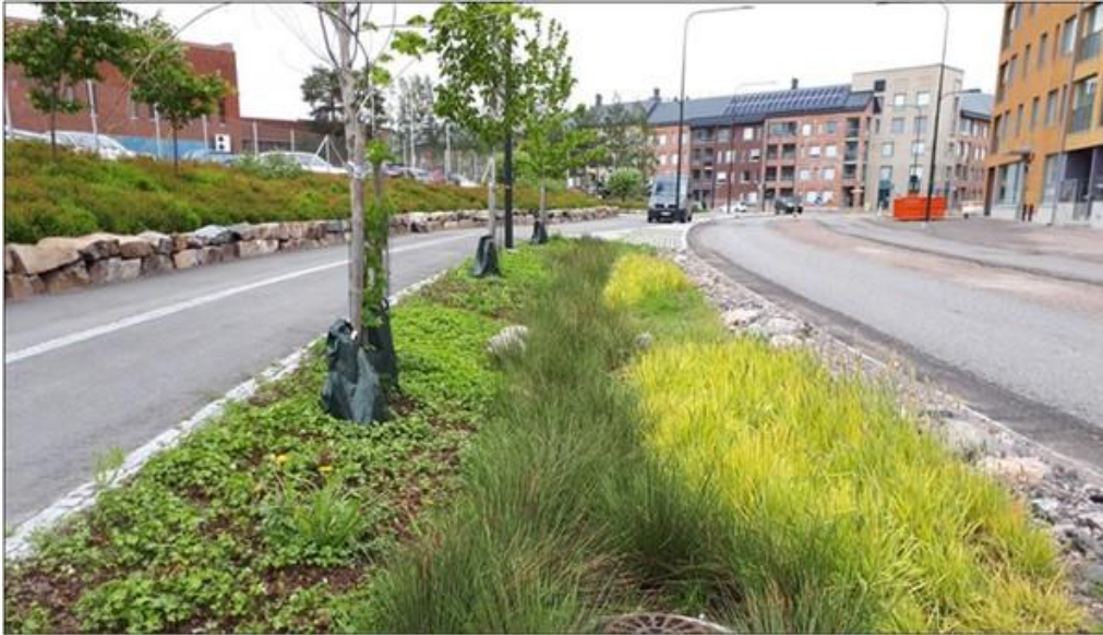
Kuva 10. Esimerkki biosuodatusrakenteesta (© Ramboll)
